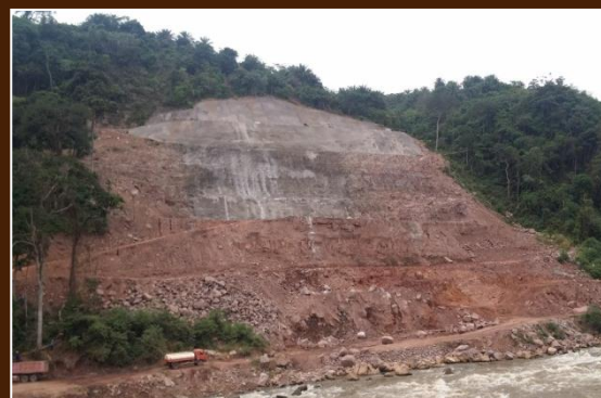
刚果（金）宗果II水电站 右坝肩边坡
