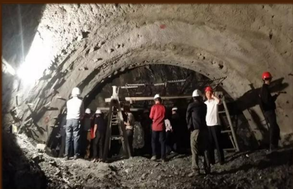
兰渝铁路新城子隧道
