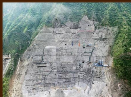
锦屏一级水电站高边坡
