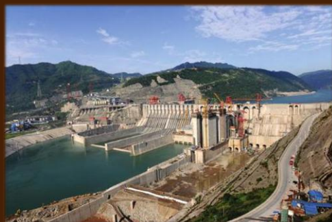
长江三峡工程高切坡
