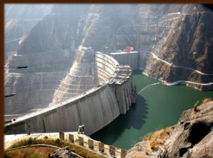
澜沧江小湾水电站
