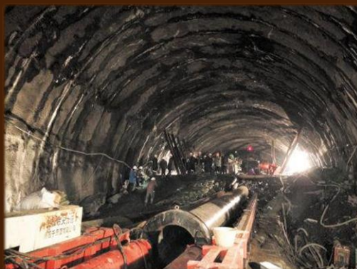
吉图珲铁路小盘岭隧道
